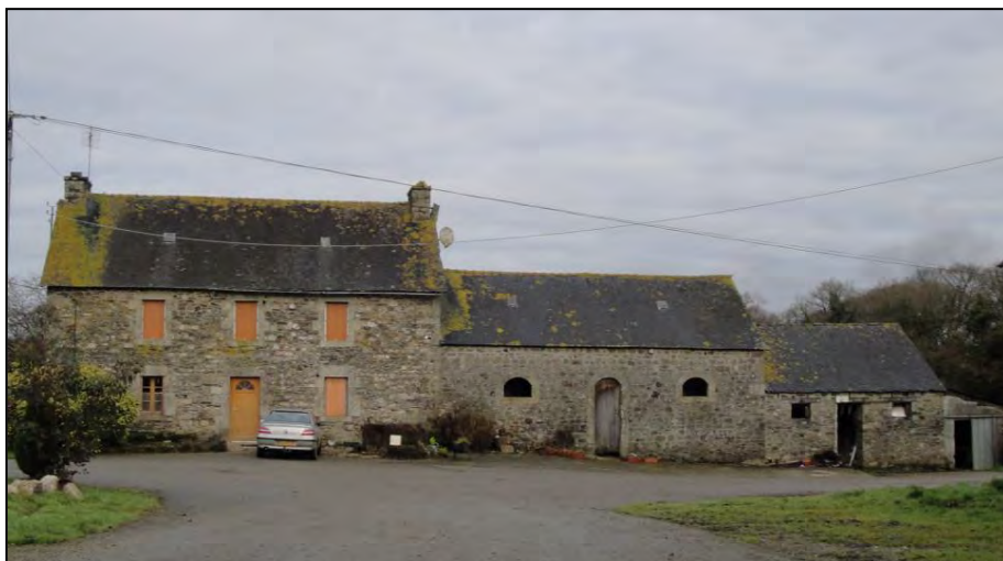
Photo n°5 : Vue sur un bâtiment à caractère patrimonial
